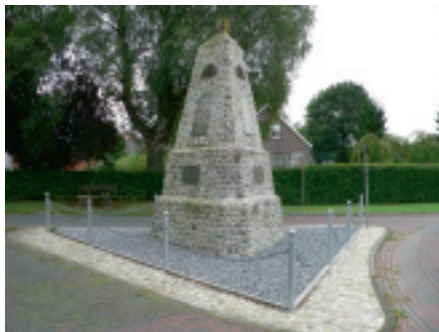
Denkmal nach der Sanierung
